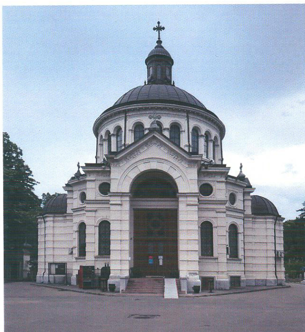
Fig. 1. Capela din Cimitirul Bellu
