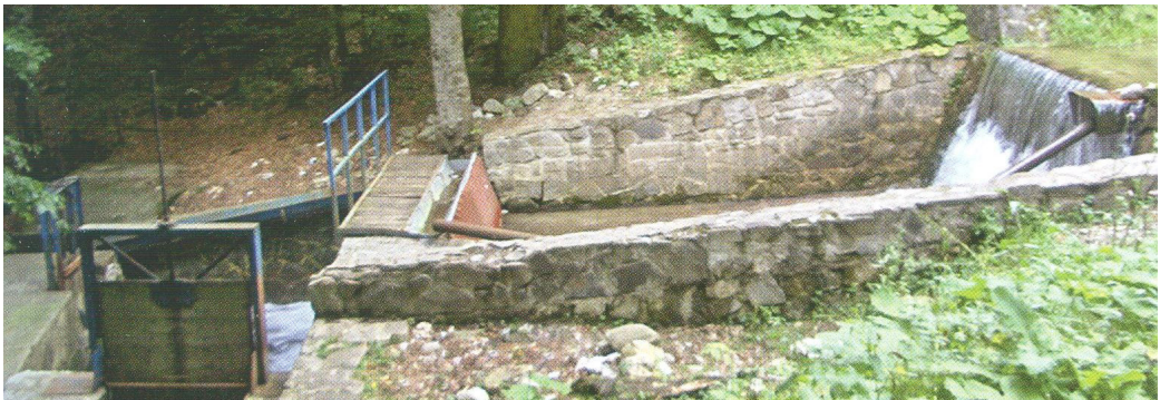
Fig. 3 Priza centralei hidroelectrice Peleş
