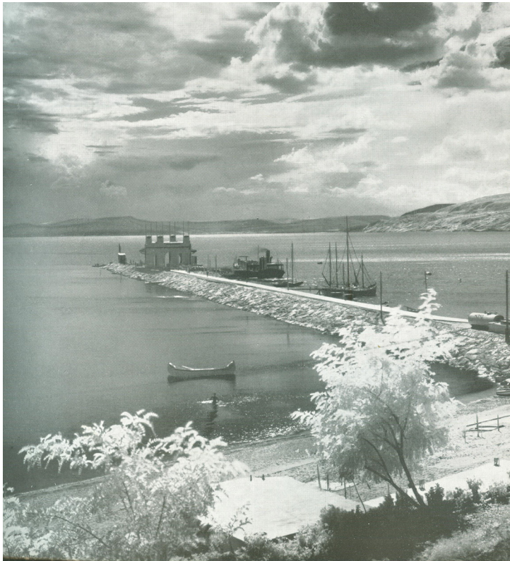
Fig. 4. Digul de la Balcic
