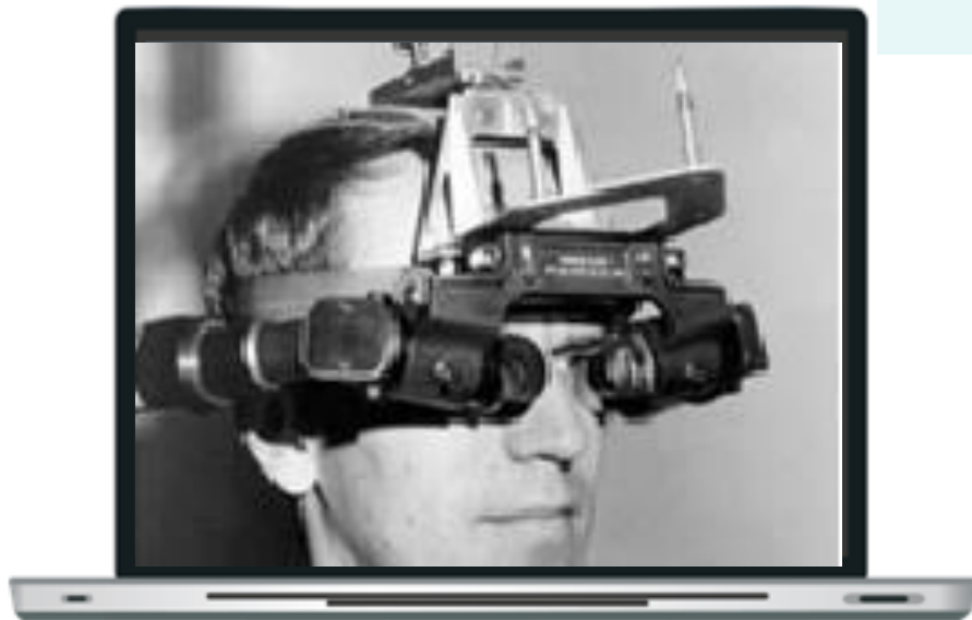
Reprezentarea primului dispozitiv pentru utilizarea AR, „Sabia lui Damocles”
